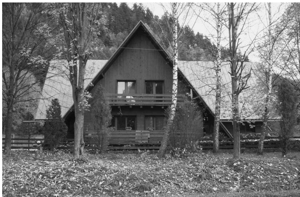
Fot. 2. Objekt Správy PIENAP-u do roku 1992.
